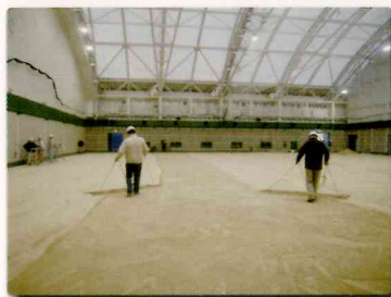
04 石灰石クラッシュ不陸整正 高度の平坦性が要求されるテニスコートの施工では、丹念に整地が行われます。
