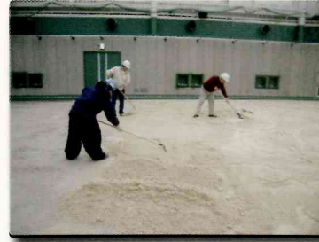
03 石灰石クラッシュ敷均し 大型重機は使用せず、人の力によって丁寧に材料を敷いていくのが伝統的なフランス式施工方法です。
