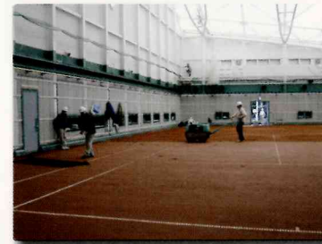
06 仕上げ ラインを設置し、転圧とネット引きにより仕上げの作業を行います。
