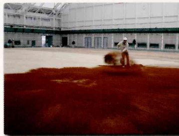
05 レッドクレイ散布状況 仕上げとしてレッドクレイを散布。転圧、散水、整地を繰り返しながらコートに赤く染め上げていきます。
