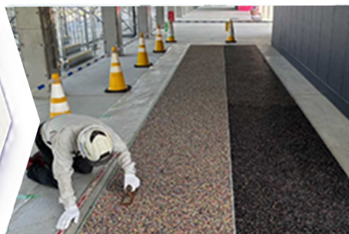
粉碎シューズを使用した舗装材の施工
