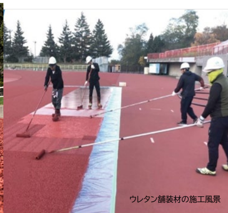
環境対応型ウレタン材「レオタンS」を使用したトラック走路
