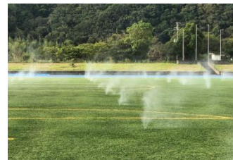
和歌山県日高郡日高川町所有の 南山スポーツ公園陸上競技場ミスト稼働状況
