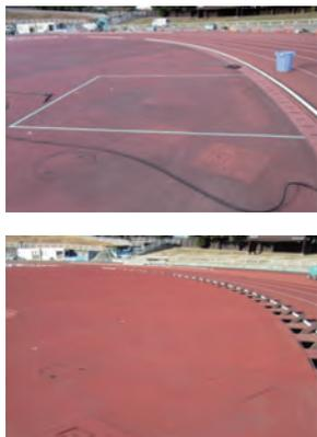
ウレタン舗装の汚れの主な原因のひとつは「カビ」です。MOSクリーン工法では、次亜塩素酸ナトリウムを含有した洗剤（MOS-A）を使ってカビを殺菌して、汚れを取り除きます。
